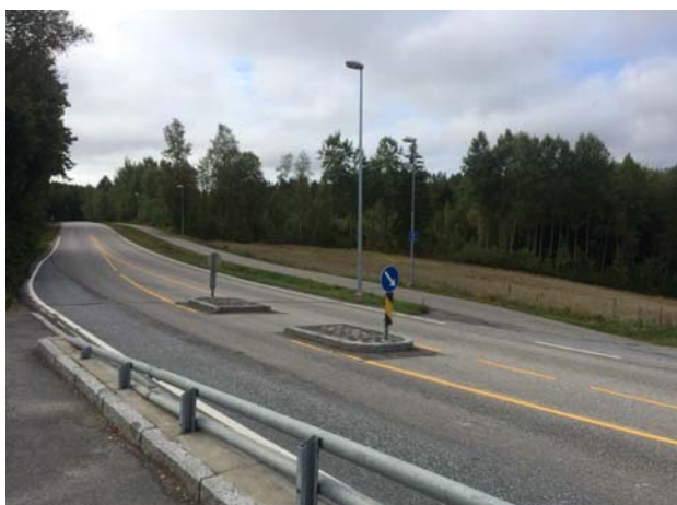
Fig 37. Bør merkes som fotgjengerovergang
