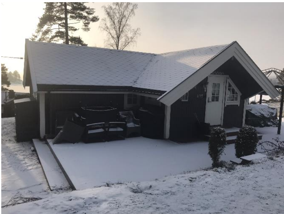
Bilde 1: Bilde av eksisterende hytte. Bilde er tatt fra flate der annekset skal bygges.
