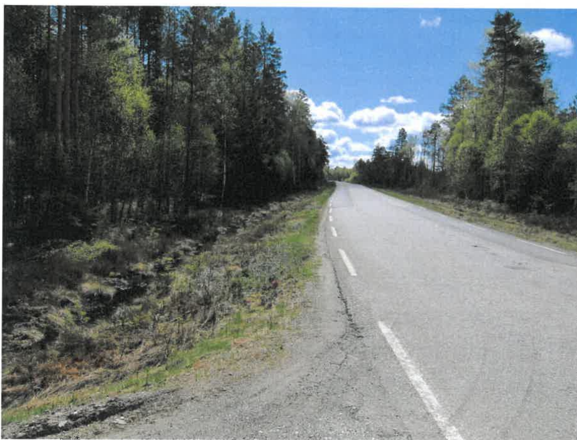
Kryss med fylkesvegen, sikt mot sør.
