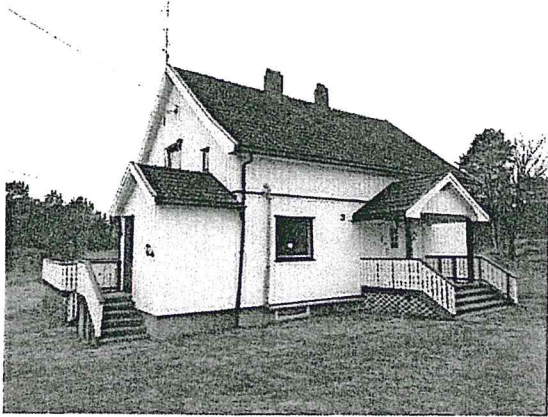
Bolighus sett fra gårdsplass. utvendig avløpsrør er i dag fjernet.
